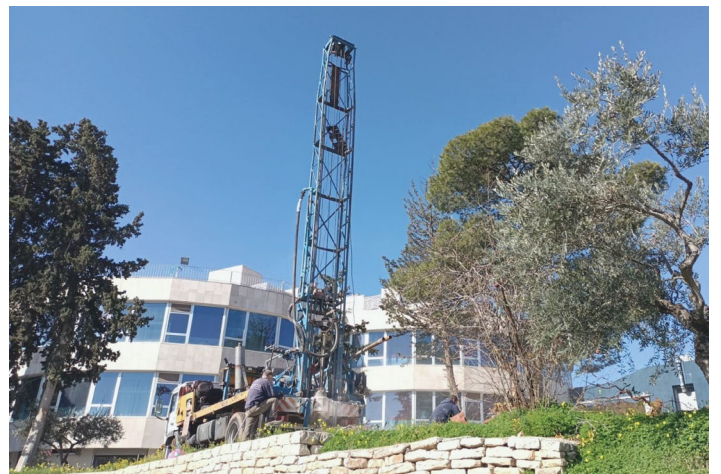
Le prélèvement d'échantillons de sol marque le début des préparatifs pour l'extension de l'hôpital pédiatrique.
