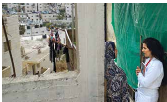
Im Winter bietet die Wohnung der Familie nur einen improvisierten Schutz vor Kälte.
